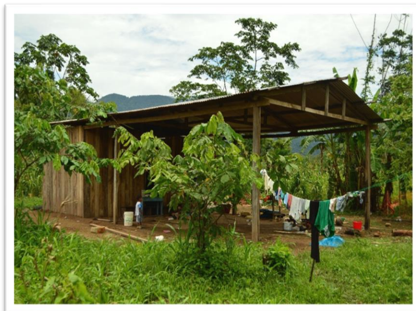
Figura N° 3. Vivienda de la Familia Shivituorori turco (F-15), quebrada Sababantiari.
