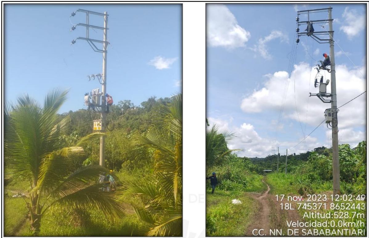
Figura 25: Tendido de Cables de Energía Eléctrica
