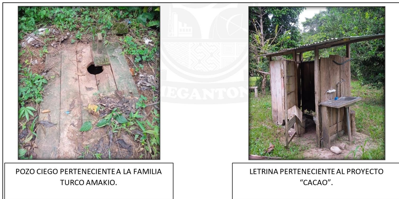
Figura 21: Pozo Ciego y Letrina en el Ámbito de Intervención
