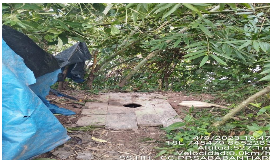
Figura N° 16: Servicio de Desagüe
