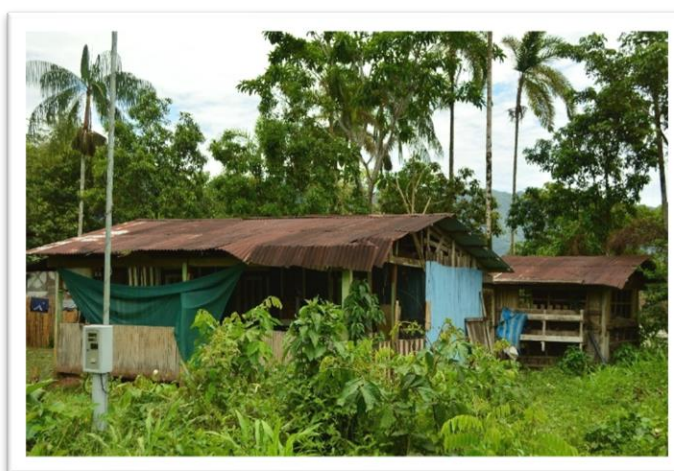
Figura N° 2. Vivienda de la Familia Martin Rios (F-13), quebrada Sababantiari.
