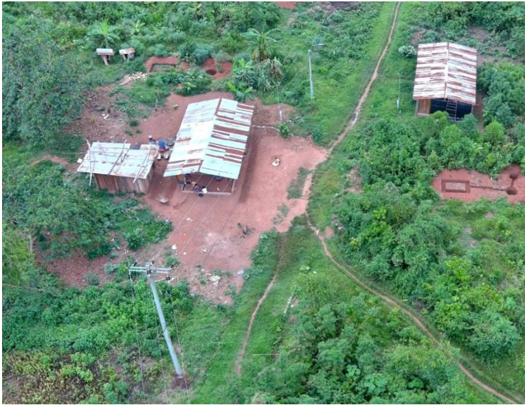
Figura N° 18: Servicio de energía eléctrica Sababantiari
