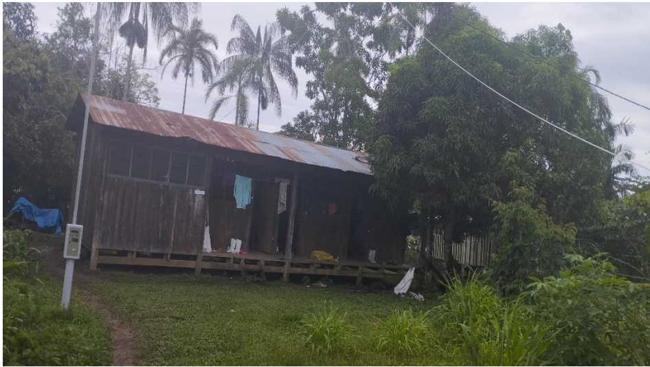
Figura N° 38:Infraestructura Proyecto Cacao
