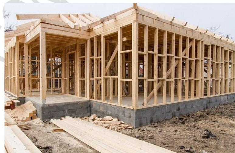
Fuente: Edificio realizado con sistema de plataforma / Guide2. 2016
