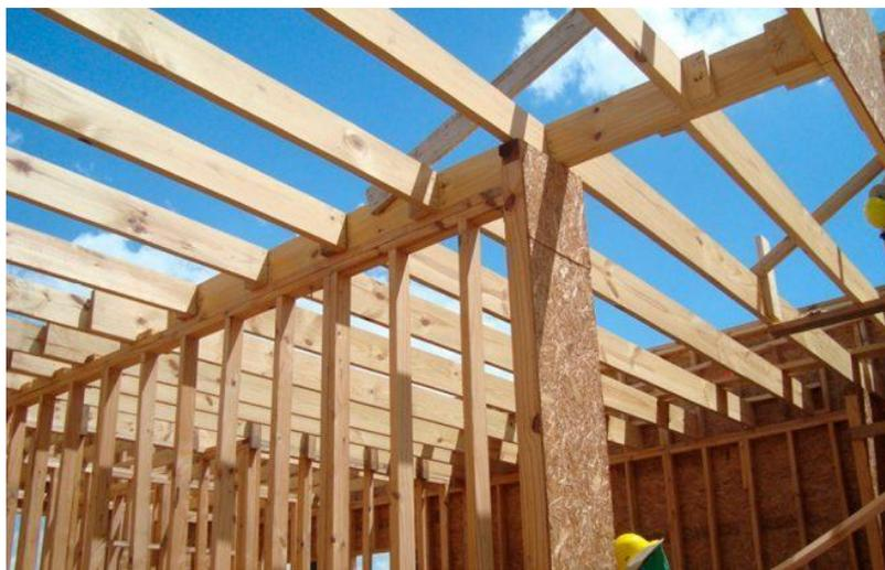
Fuente: Sistema constructivo de poste y viga / Min de Agricultura, Ganadería y Pesca. 2016
